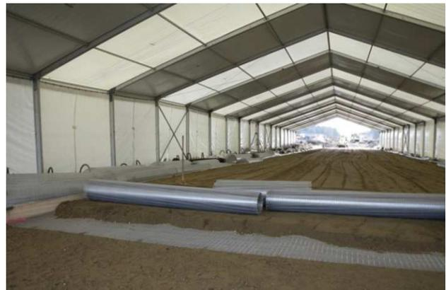
Bild 8: Einbau der Geogitter
