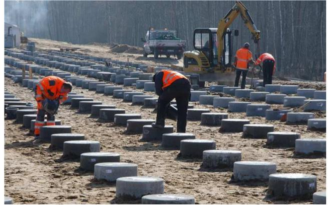
Bild 7: Herstellen der Pfahlköpfe aus Fertigteilen
