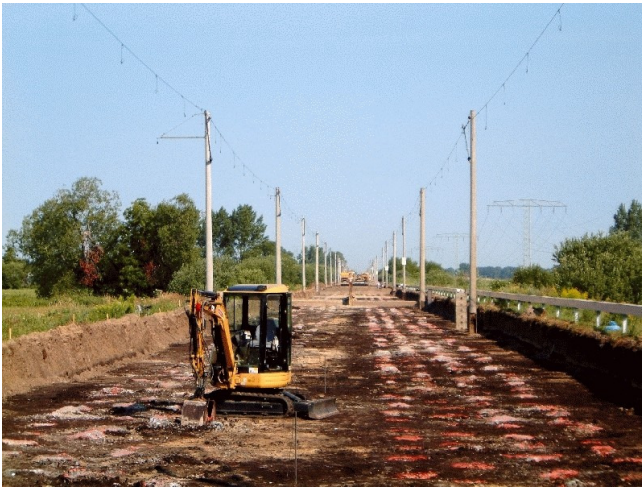
Bild 10: Abtragsniveau bei -2,7 m unter SO
