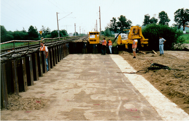
Bild 3: Großschurf im Sommer 2001; eingepresste Spundwände und freigelegtes Geogitter
