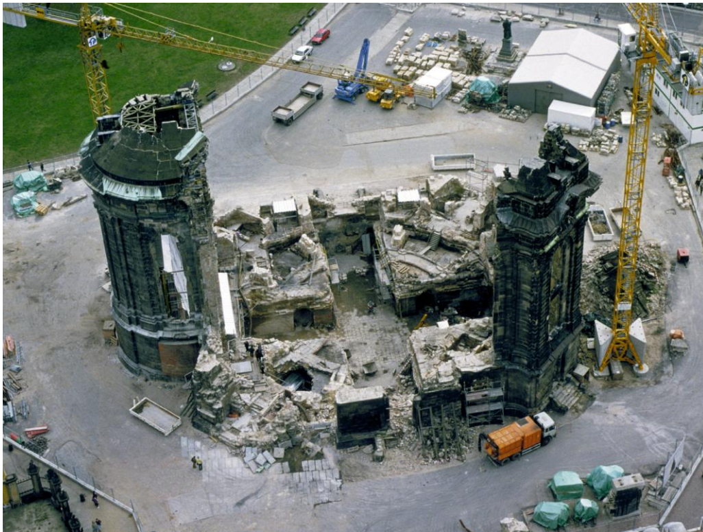
Bild 4 Freigelegte Fundamente nach Abtrag des Trümmerberges im Jahre 1994
