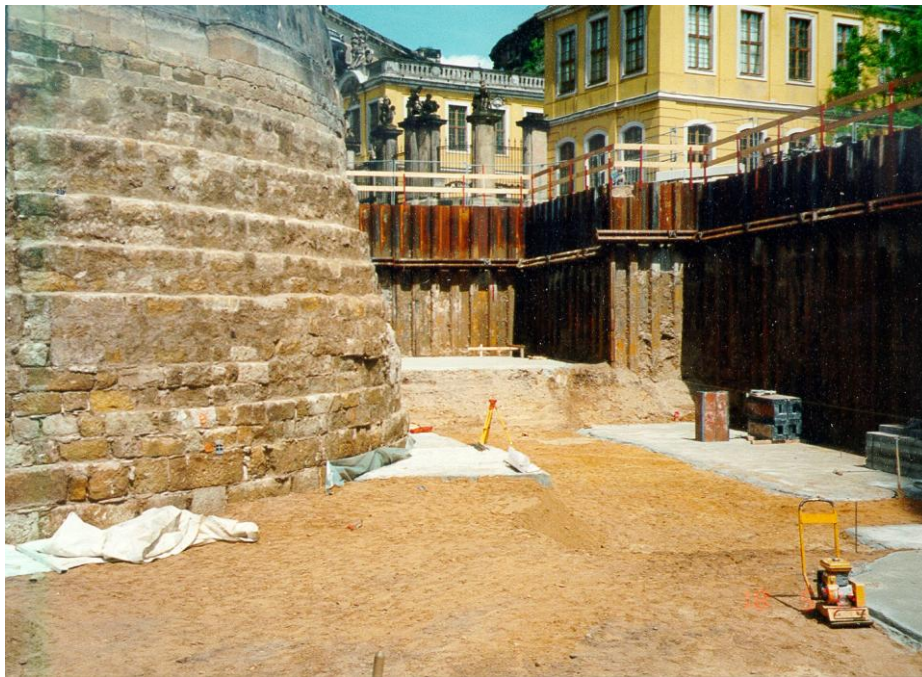
Bild 7 Baugrube für das Außenbauwerk mit Spundwandverbau und freigelegtes Außenmauerfundament im Jahre 1995
