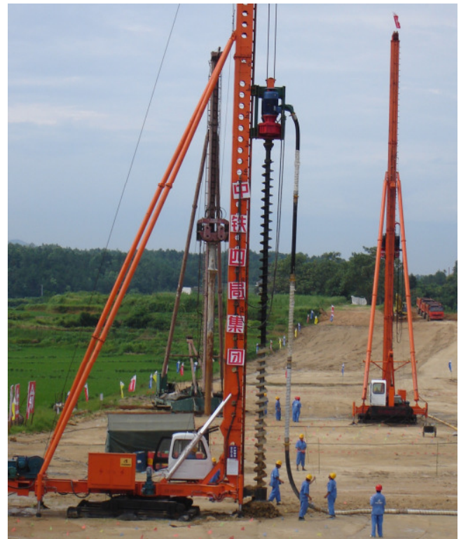
Bild 11: Herstellung von mit CFG-Piles
