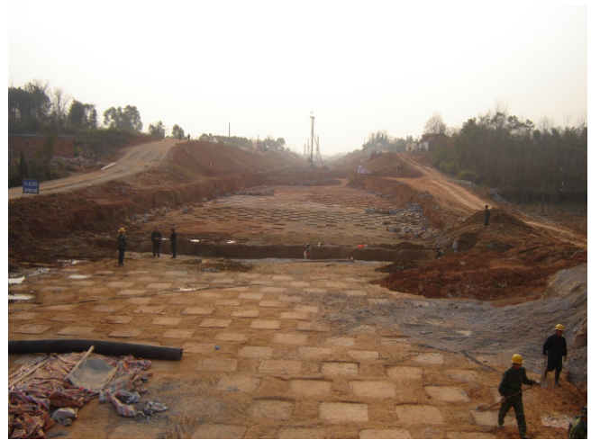
Bild 2: Erdbau und Untergrundverbesserungsmaßnahmen
