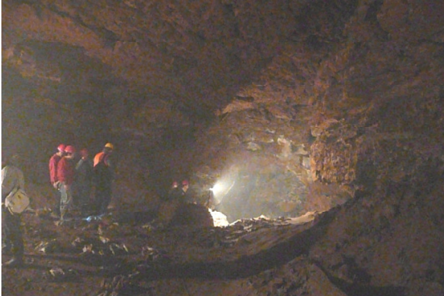
Bild 9: Karststrukturen im Tunnel
