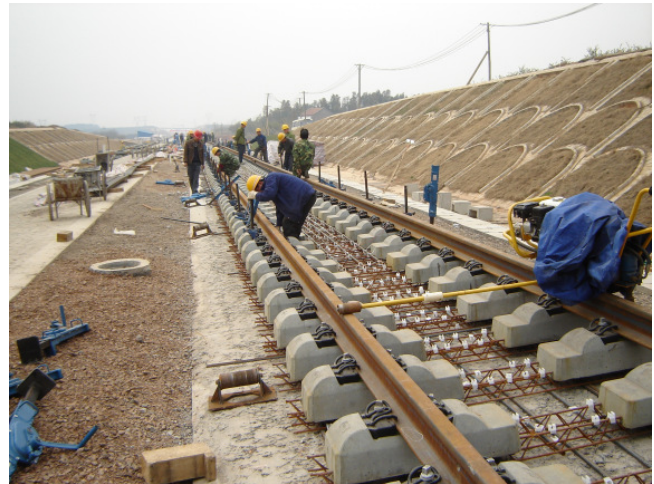
Bild 12: Vorbereitungen zum Einbau der Festen Fahrbahn in einem Einschnitt
