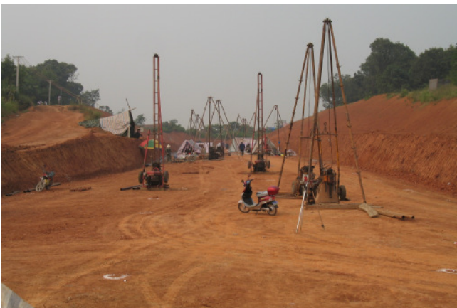
Bild 10: Karstinjektionen in einem Einschnitt
