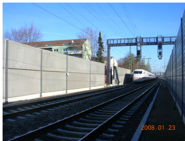
Bild 9: Lärmschutzwand System Züblin mit Pfahlabstand von 7,5 m (Quelle: Züblin)
