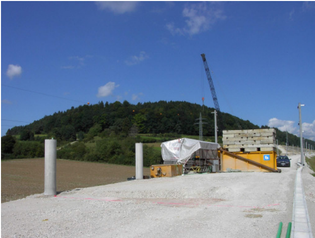
Bild 3: Pfahlprobelastungen mit zyklischer horizontaler Beanspruchung
