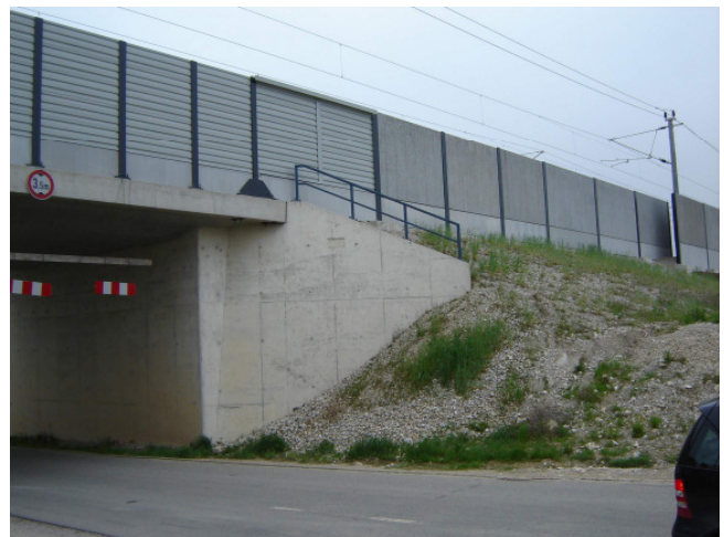
Bild 1: Lärmschutzwand an der NBS Nürnberg – Ingolstadt
