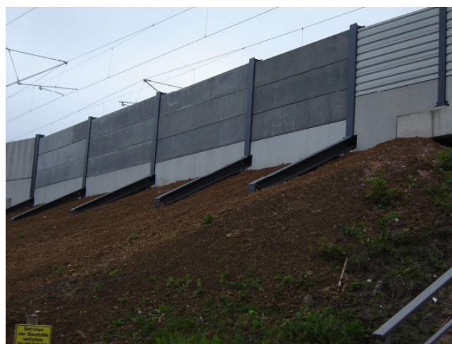
Bild 7: Ertüchtigte Gründung für die Lärmschutzwände im BA 1.2 der NBS Nürnberg – Ingolstadt
