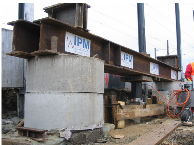
Bild 8: Zyklische axiale Pfahlprobebelastung (Quelle: ARCADIS)
