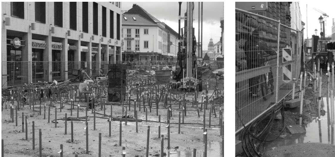
Abb. 7: Injektionsbohrungen unter beengten Platzverhältnissen
