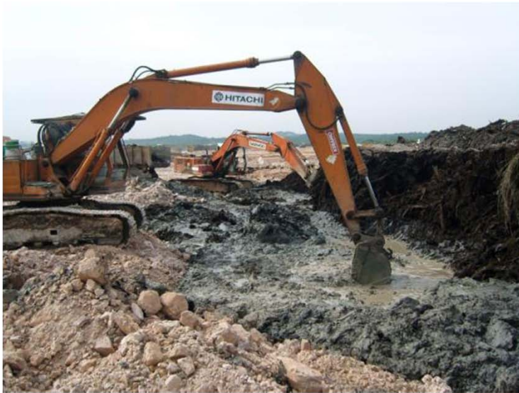
Bodenhebung im Torf und Schlick bis zu 3 m
