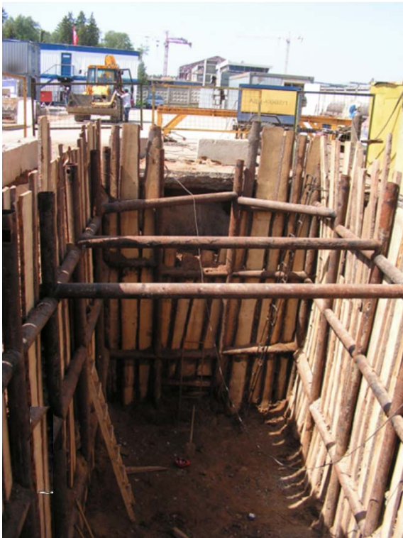
Russischer Baugrubenverbau
