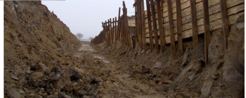
Russischer Baugrubenverbau
