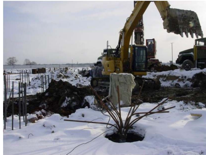
Verschütteter Bohrfahl
