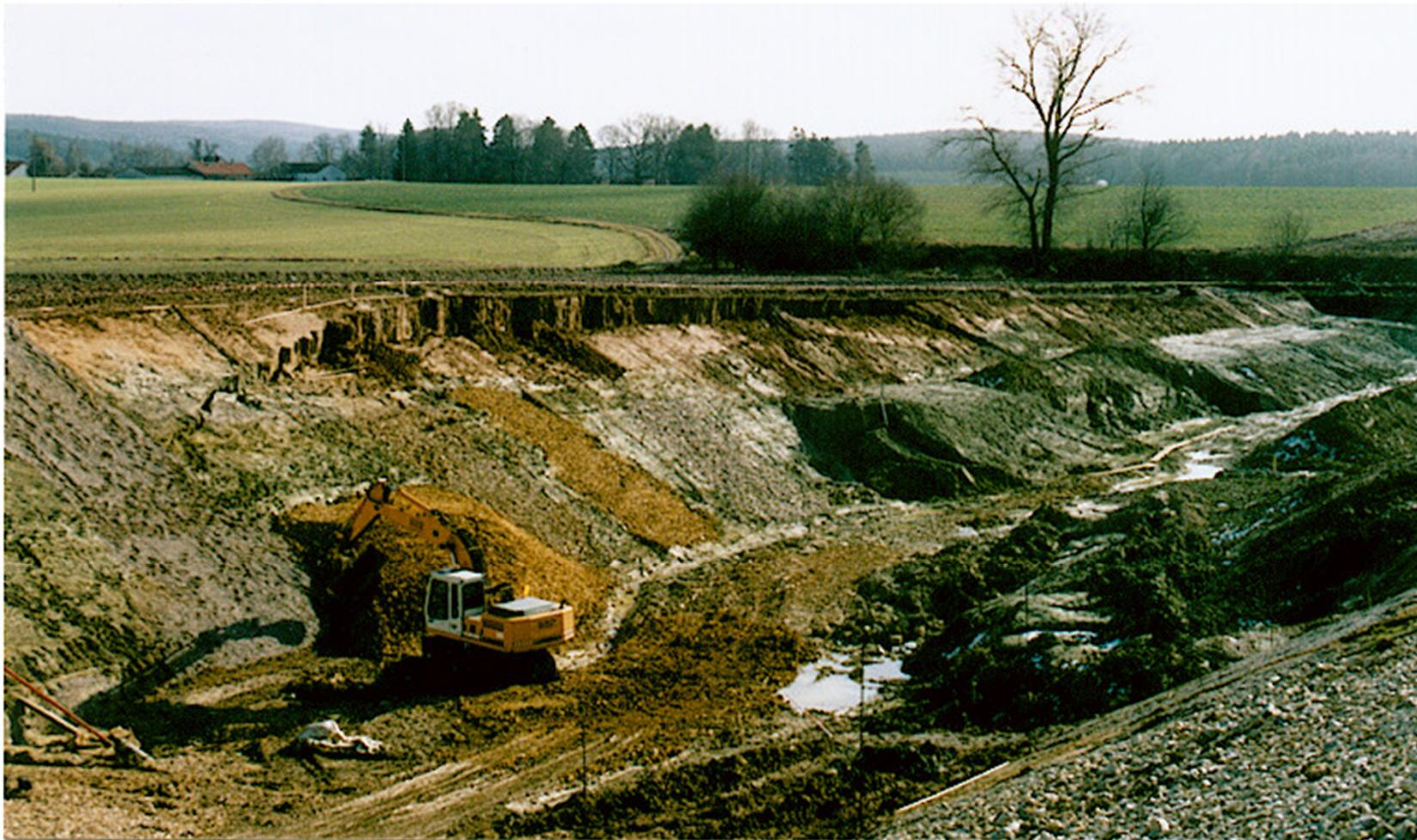
**Rutschung an der Ostböschung des Einschnittes E 2 im Los Süd vom 05./06. Februar 2000**
