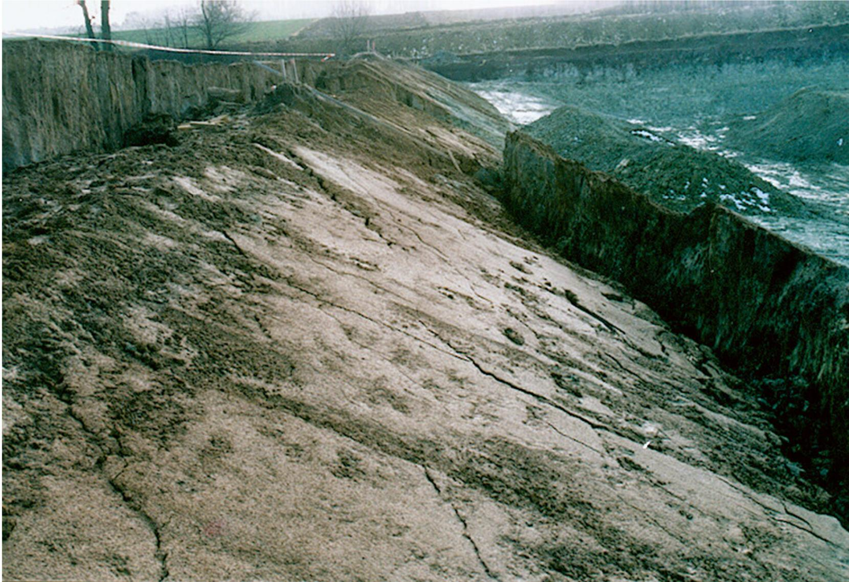
**Struktur des Rutschkörpers im Einschnitt E 2 vom
