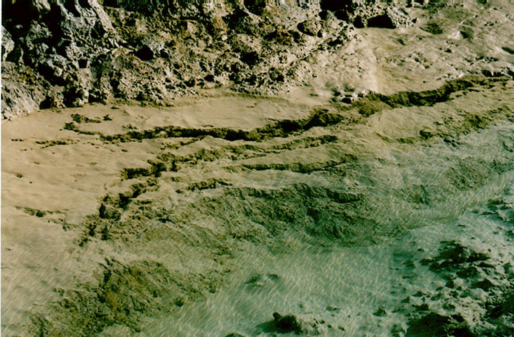
**Austritt der Gleitfläche am Böschungsfuß (Rutschung an der Ostböschung des Einschnittes E 2 im Los Süd vom 05./06. Februar 2000)**
