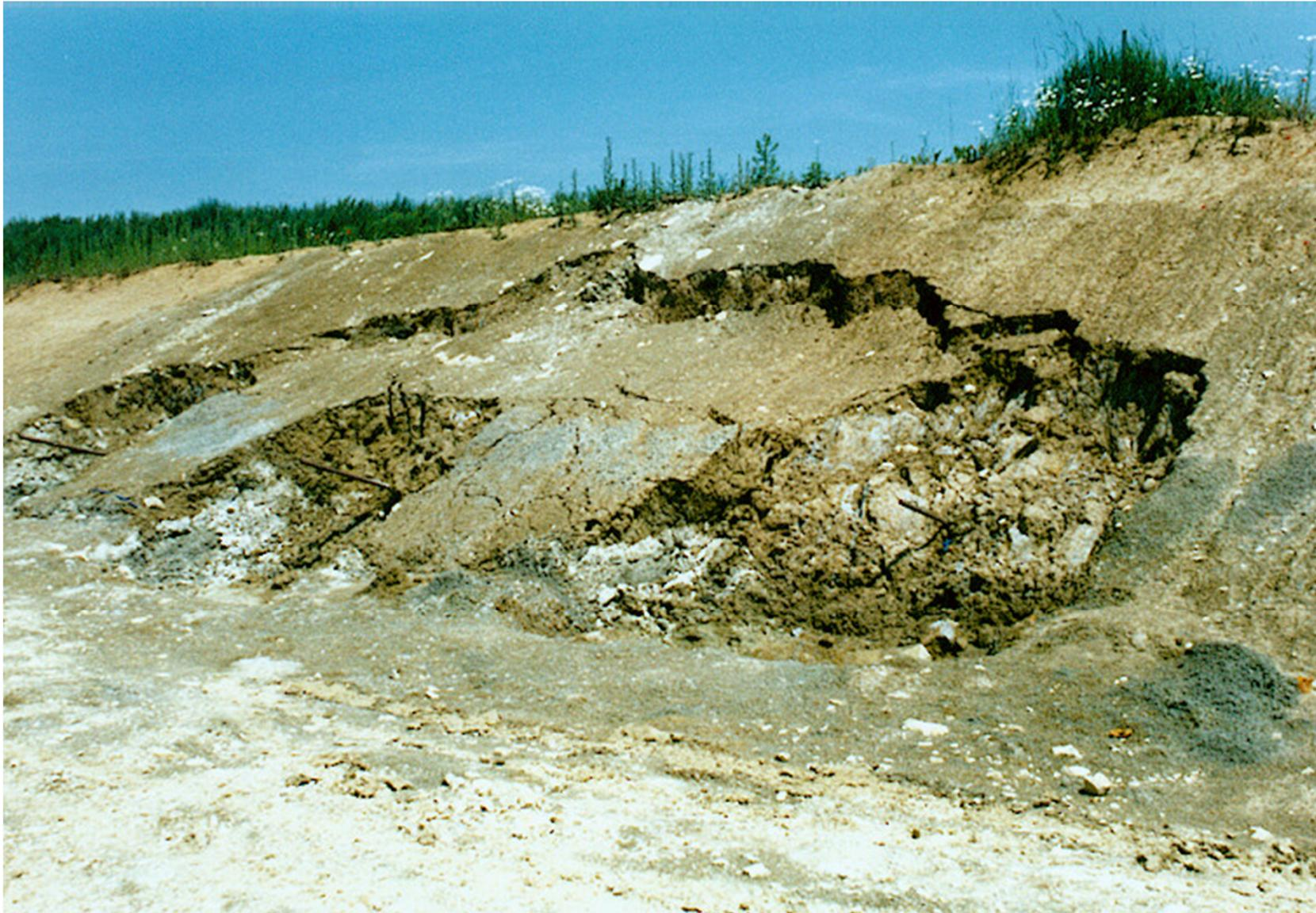
**Rutschung an der Ostböschung des Einschnittes E 2 im Los Süd nach Ausführung von Ankerzugversuchen im Juni 2001**
