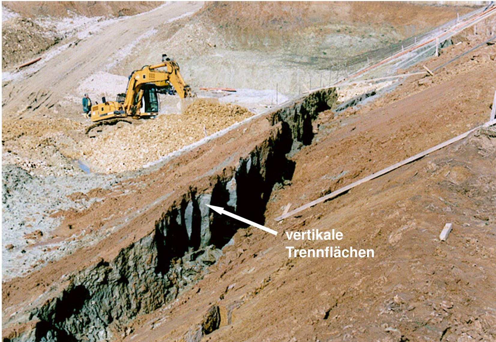
**Untere Bruchfläche der Rutschung an der Ostböschung des Einschnittes E 2 im Los Süd vom 05./06. Februar 2000**
