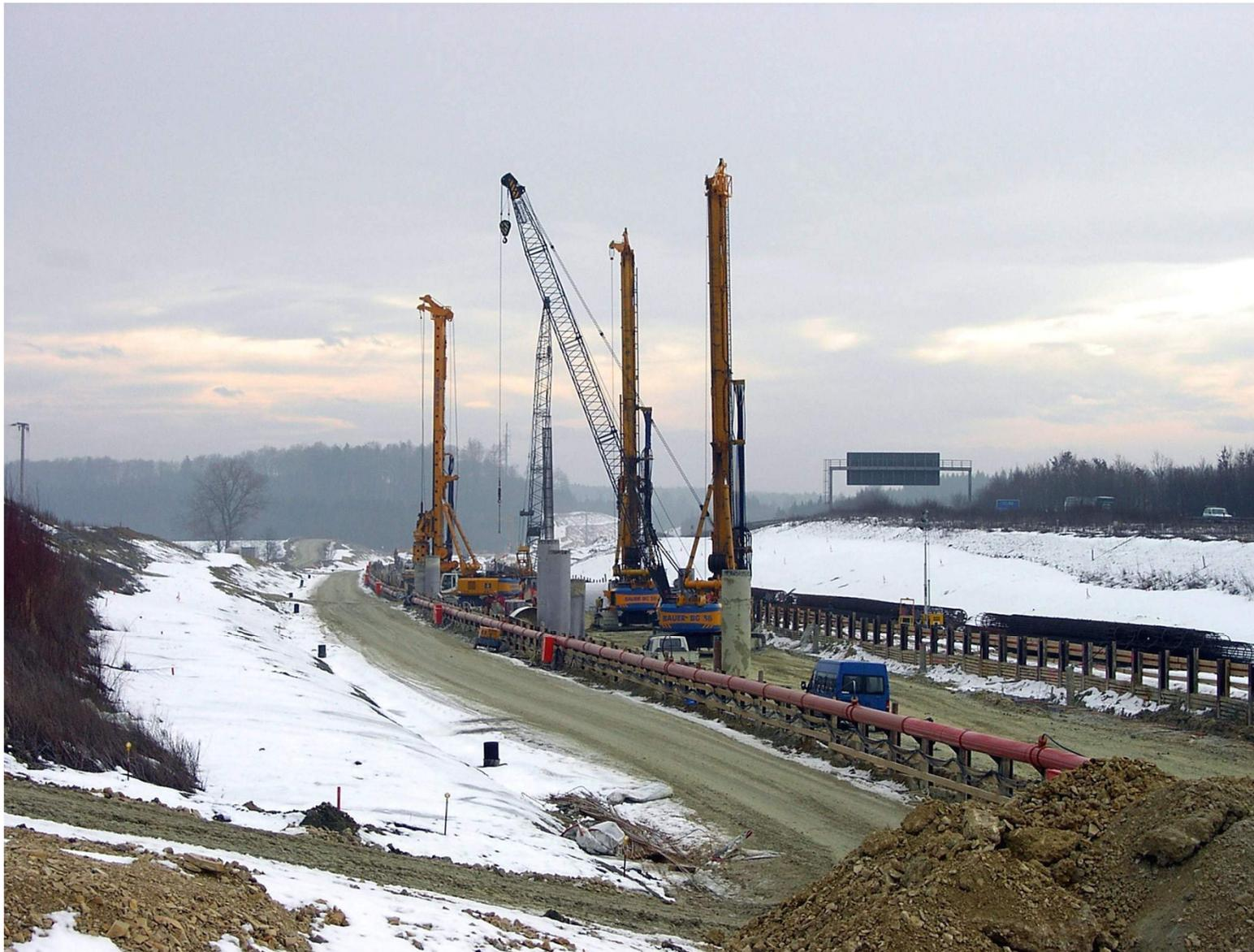
**Herstellung der Bohrpfehlwände für den Tunnel „E 2“ im Januar 2003**
