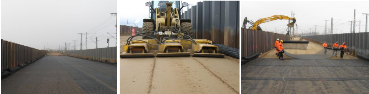
Bild 8: Einbau der Geogitter zwischen den Spundwänden
