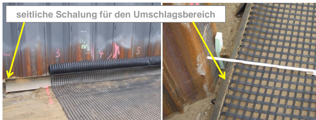
Bild 7: seitliche Schalung zum Umschlagen der Geogitterquerlagen
