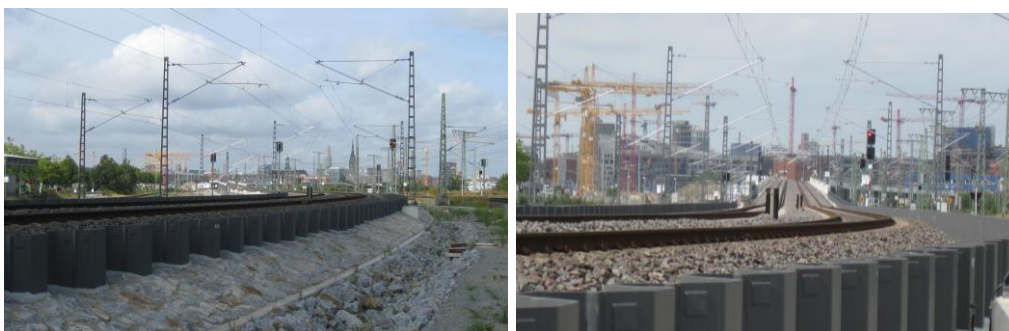
Bild 11: fertige Pfeilerbahn, links im Bereich der Kurve, rechts im Bereich der Rampe zum Kreuzungsbauwerk (Datum: September 2009)
