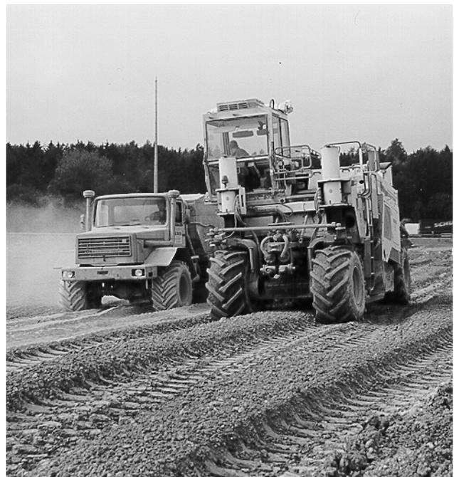
Bild 6: Einbau einer bindemittelverbesserten Schicht auf einem Probefeld im Los Süd
