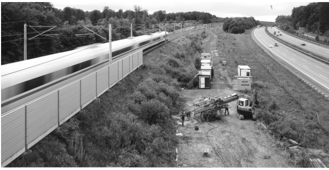
Bild 2. Örtliche Situation, Blick Richtung Köln
